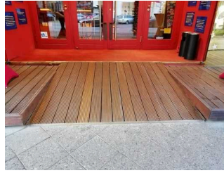
Rampe am Eingangsbereich
